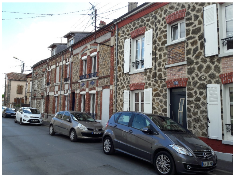
Ensemble 4 au 16 rue Mirabeau
