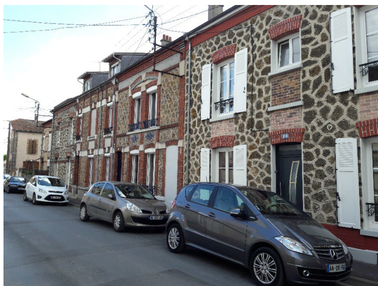
Ensemble 4 au 16 rue Mirabeau
