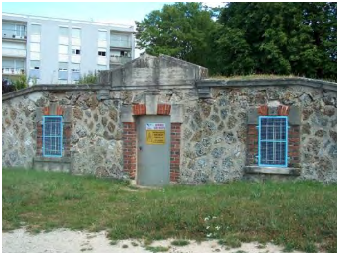
Réservoir des Pavements
