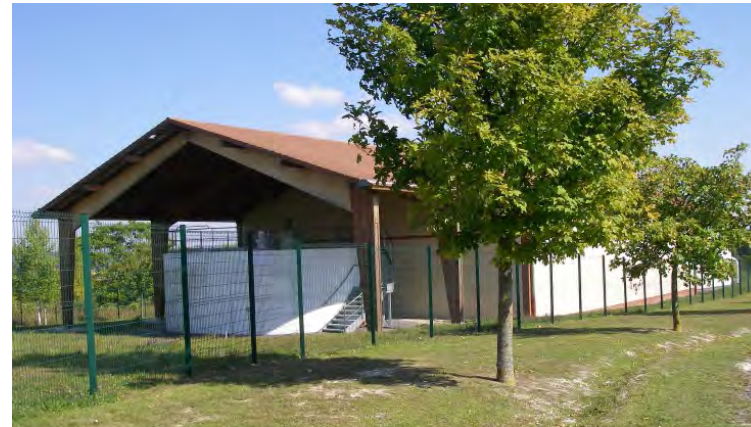
Usine de traitement de Belle-Noue à Epernay
