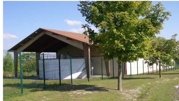
Usine de traitement de Belle-Noue à Epernay
