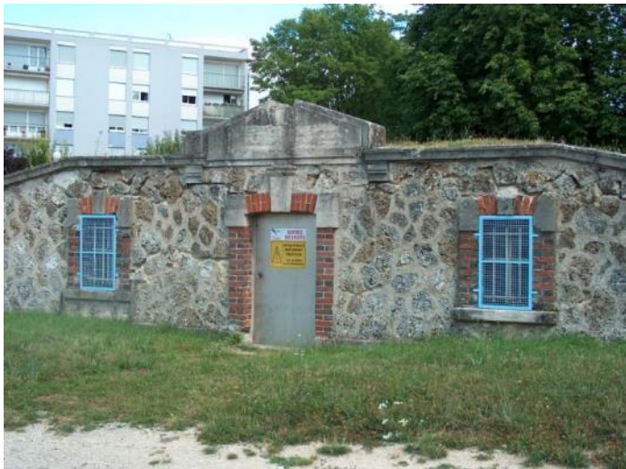
Réservoir des Pavements
