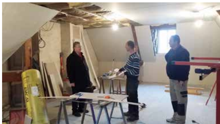
Isolation thermique et aménagement du grenier de la Maison Heureuse
