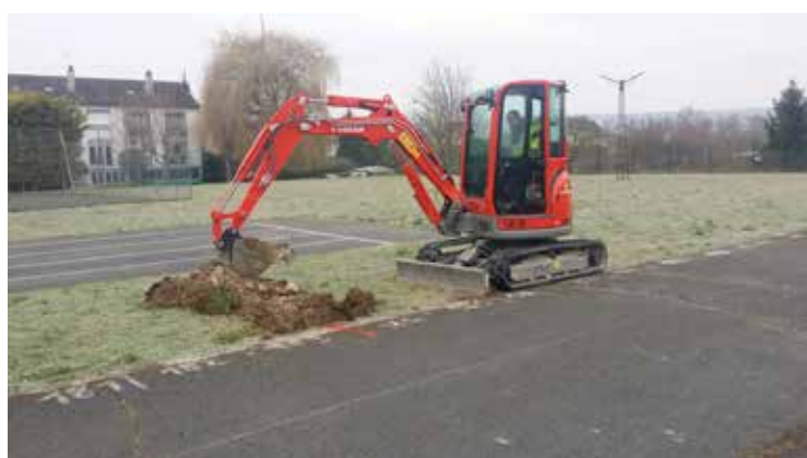
Electrification du terrain de sports
